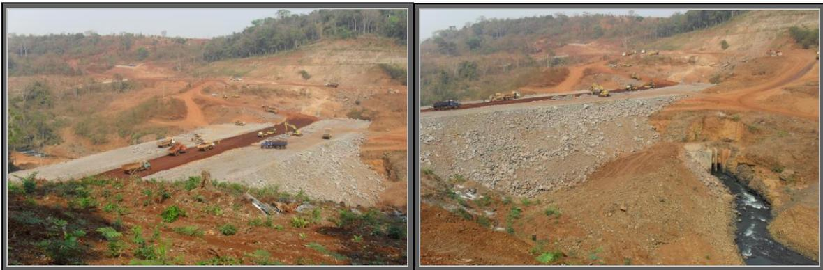
**Figura 6.2 – Exemplo de barragem em enrocamento em construção, similar ao projeto da PCH Cavernoso V**
