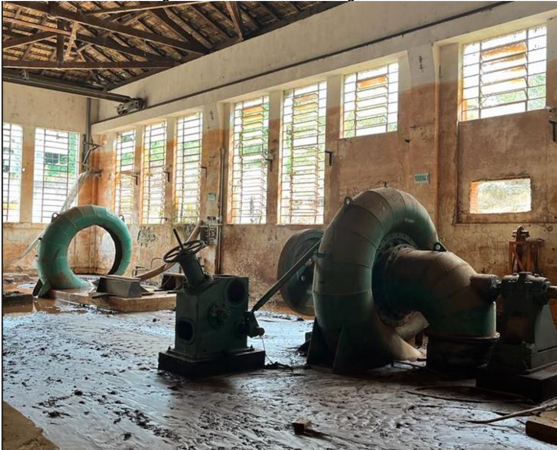
Figura 34 – Turbinas da antiga usina.
