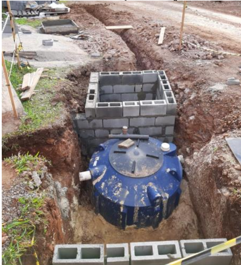
Figura 43 - Instalação de biodigestor
