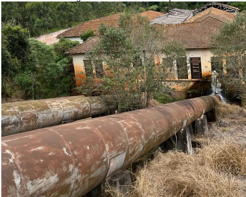
Figura 29 - Detalhe dos berços
