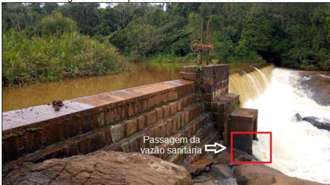
Figura 17 - Comporta desarenadora do barramento
