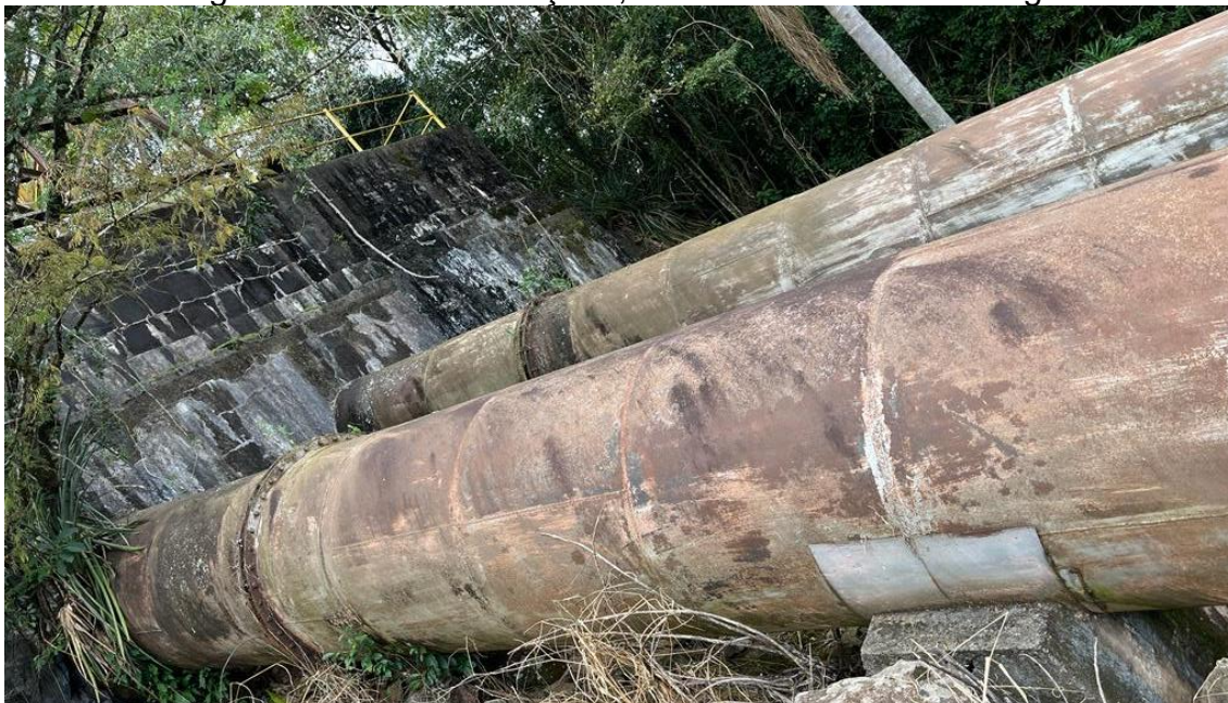
Figura 28 - Conduto forçado, saindo da câmara de carga
