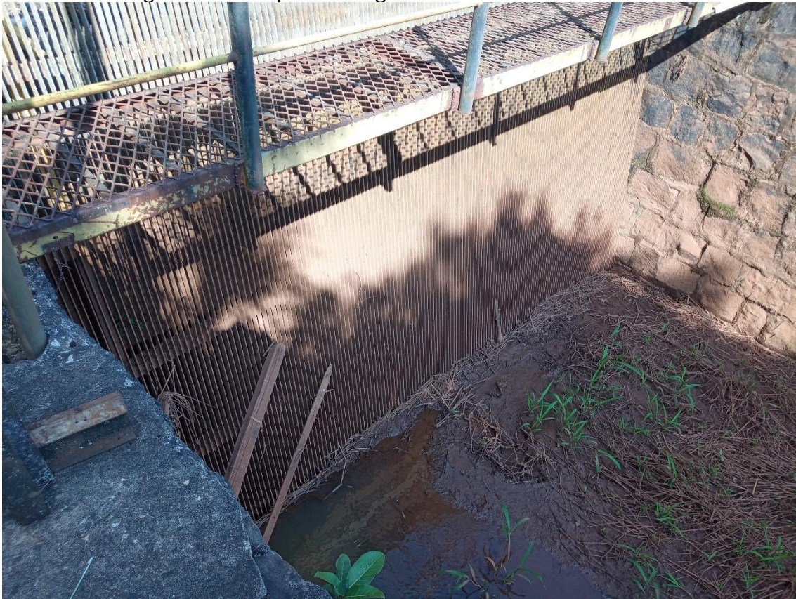
Figura 25 - Limpeza das grades e de dentro da câmara
