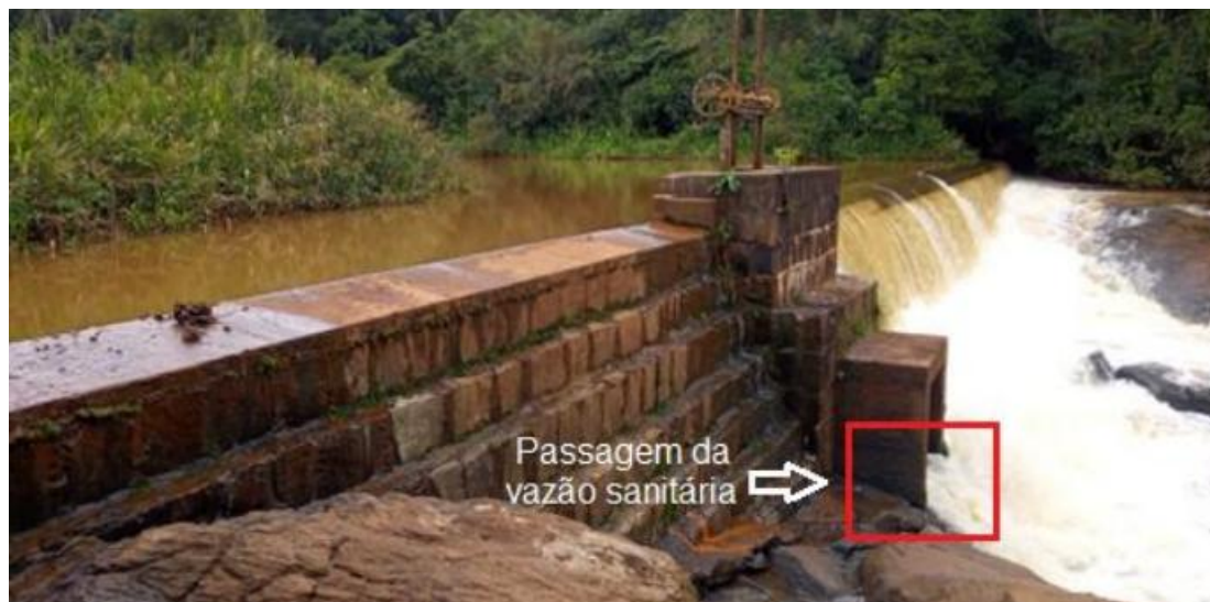
Figura 50 - Passagem da vazão sanitária Fonte: Memorial Descritivo da CGH Tamarana.
