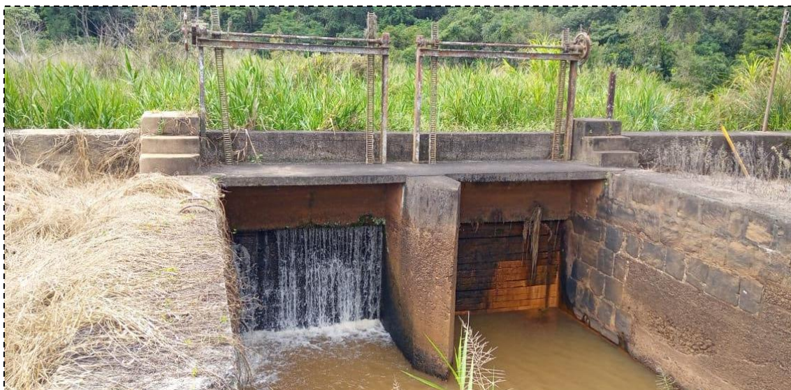
Figura 9 – Tomada d'água. Foto: Memorial Descritivo
