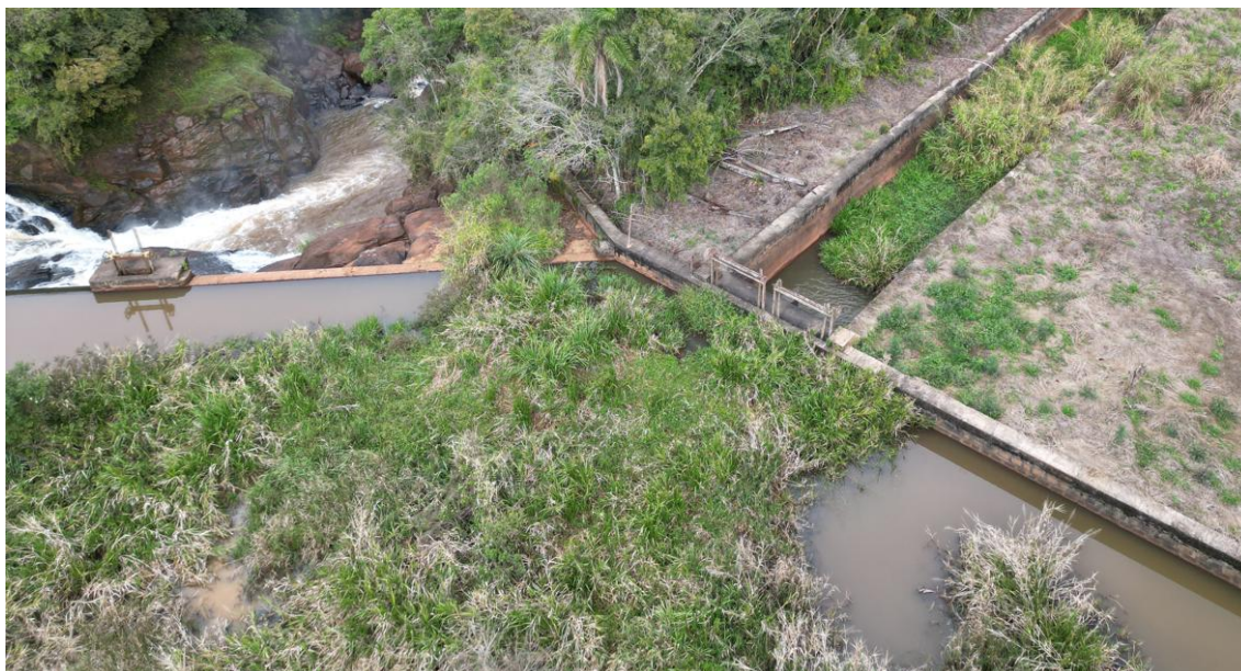
Figura 46 - Vegetação dentro da tomada d'água, parte do reservatório e canal de adução
