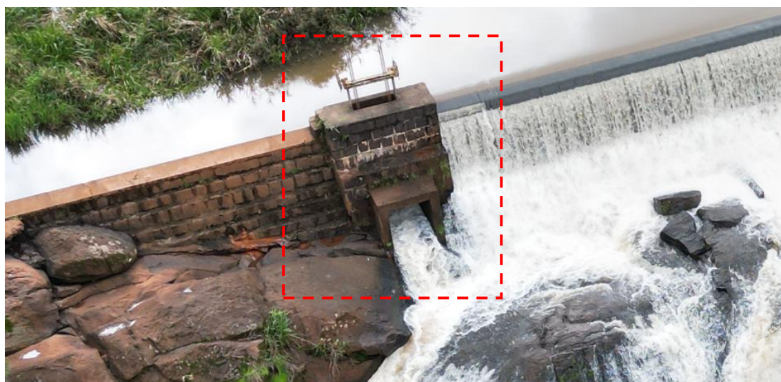
Figura 47 - Comporta desarenadora
